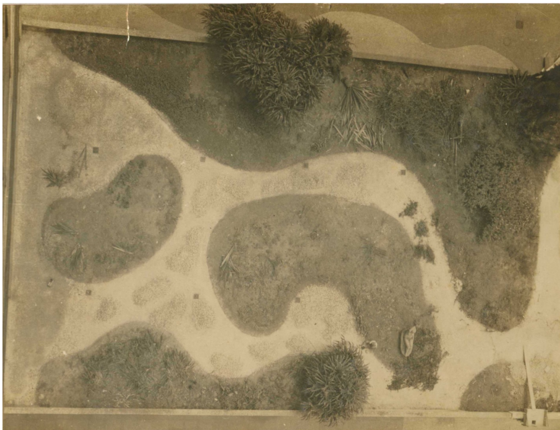
Figura 11 - Fotografia do início das obras de impermeabilização do terraço-jardim do segundo pavimento, o primeiro registro fotográfico de uma intervenção no edifício após o tombamento. Foto: DPHAN, fev. 1955. Fonte: ACI/RJ. Processos de intervenção fora da Série Obras – Cx. 00/P. 01-1. Pode-se perceber que o traçado dos canteiros já é distinto tanto daquele à época da inauguração (Figura 4), quanto do seu formato atual (Figura 5).
