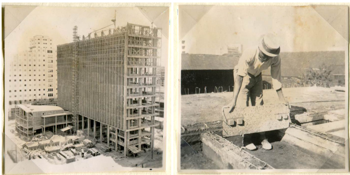
Figura 8 e Figura 9 – Fotografias da construção do edifício, que compõem um conjunto de cerca de 700 imagens captadas entre os anos de 1937 e 1938, registrando as etapas iniciais da construção do prédio, correspondentes à execução de sua estrutura e alvenarias. Fonte: ACI/RJ.
