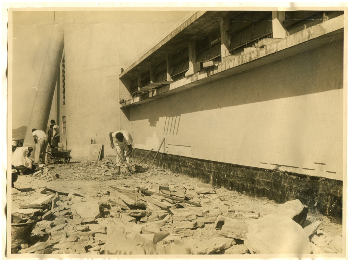
Figura 14 – Fotografia da troca de impermeabilização no terraço do 16º pavimento, uma das poucas imagens relativas ao edifício que compõem a Série Obras. Foto: Serviço Fotográfico da Sede do MEC, out. 1962. Fonte: ACI/RJ. Série Obras – Cx. 0543/P. 1586.
