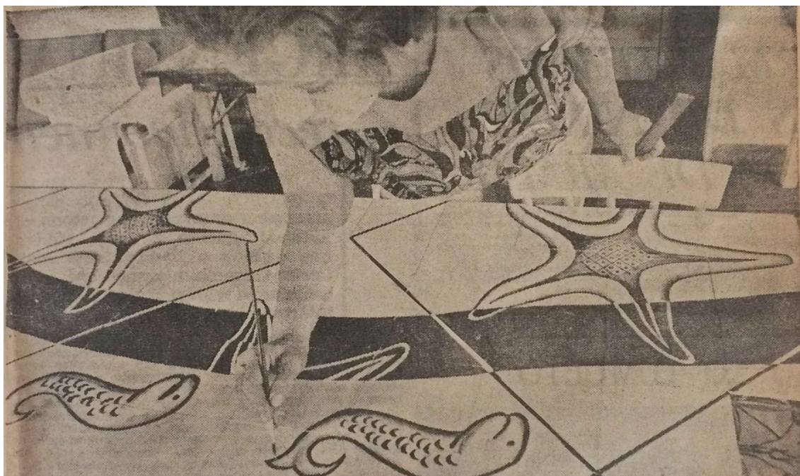
Figura 17 – Reprodução, por Hilda Goltz, de peças faltantes dos painéis de azulejos, a partir de desenhos elaborados pela DPHAN. O Globo , 13 jun. 1970, p. 8. Fonte: ACI/RJ. Série Obras – Cx. 0543/P. 1587.
