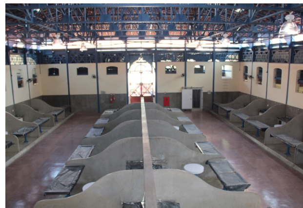
Fig. 36: Piso em korodur revitalizado e pintura das paredes. Fonte: Acervo Iphan, 2015.
