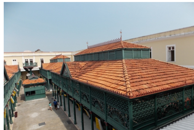
Fig. 10: Pavilhões metálicos no Mercado Francisco Bolonha. Foto: Giovanni Blanco Sarquis, 2014.
