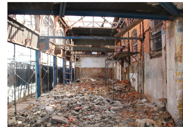
Fig. 20: Lojas com alterações indevidas sendo demolidas. Foto: Giovanni Blanco Sarquis, 2014.
