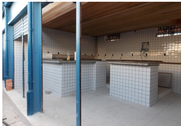
Fig. 30: Loja com revestimento cerâmico novo. Foto: Giovanni Blanco Sarquis, 2014.
