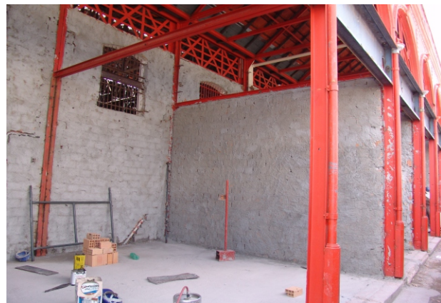
Fig. 28: Nova alvenaria e estrutura metálica recuperada. Fonte: Acervo Iphan, 2012.
