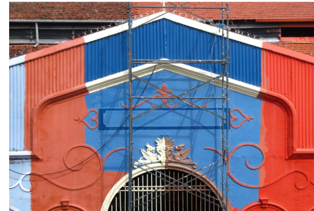
Fig. 43: Teste do tipo e cor da tinta da fachada. Foto: Giovanni Blanco Sarquis, 2014.
