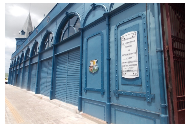
Fig. 45: Restauração e revitalização de elementos da fachada. Foto: Giovanni Blanco Sarquis, 2014.
