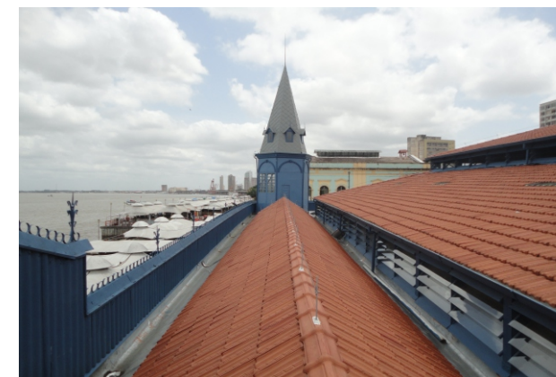
Fig. 42: Cobertura com novo revestimento cerâmico. Foto: Giovanni Blanco Sarquis, 2013.
