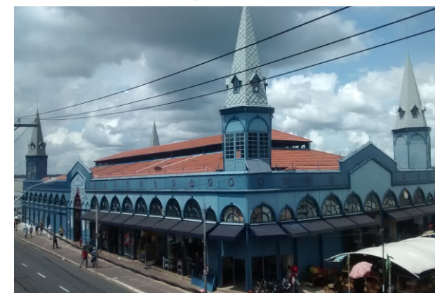
Fig. 46: Vista geral da obra concluída. Foto: Giovanni Blanco Sarquis, 2015.
