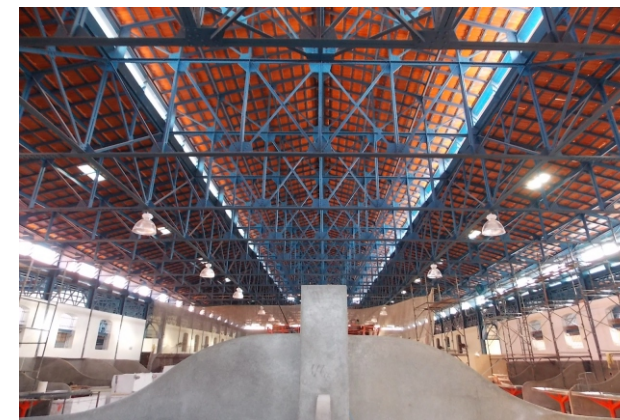
Fig. 41: Estrutura metálica da cobertura restaurada. Foto: Giovanni Blanco Sarquis, 2014.
