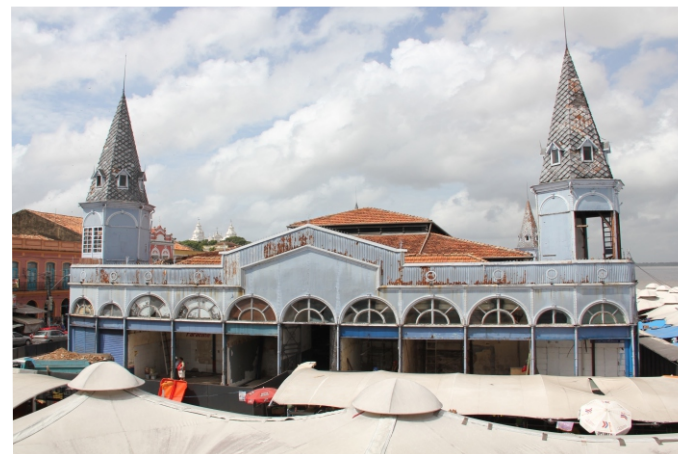
Fig. 15: Vista externa pouco antes do início da obra. Fonte: Acervo Iphan, 2012.
