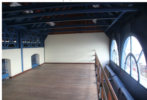
Fig. 32: Mezanino concluído (assoalho, guarda-corpo e parede novos). Fonte: Acervo Iphan, 2013.
