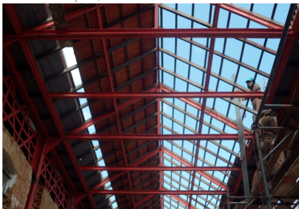
Fig. 29: Estrutura metálica da cobertura substituída. Foto: Giovanni Blanco Sarquis, 2013.
