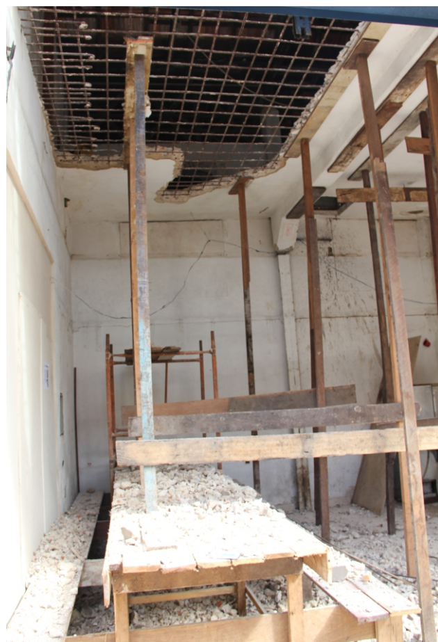
Fig. 17: Laje de concreto no mezanino da loja. Fonte: Acervo Iphan, 2012.
