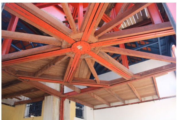
Fig. 39: Consolidação estrutural das torres metálicas. Foto: Giovanni Blanco Sarquis, 2014.
