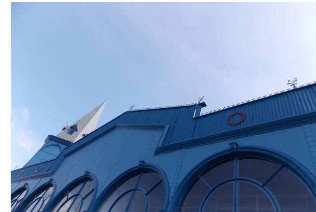
Fig. 44: Novos vidros e elementos metálicos recuperados Foto: Giovanni Blanco Sarquis, 2014.
