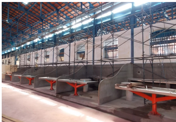
Fig. 35: Recuperação de paredes de alvenaria e estruturas metálicas. Foto: Giovanni Blanco Sarquis, 2014.
