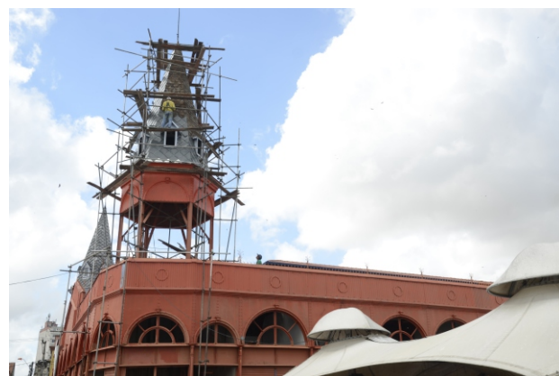
Fig. 40: Restauração das torres metálicas. Fonte: Acervo Iphan, 2012.
