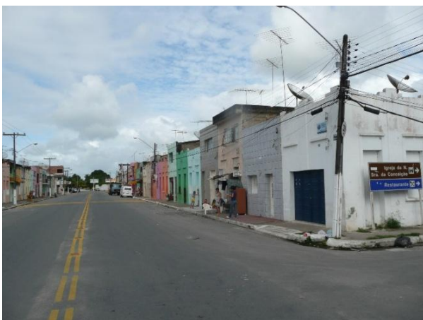
Figura 08: Vila Operária de Goiana, PE. Fonte: IPHAN – PE, 2009.
