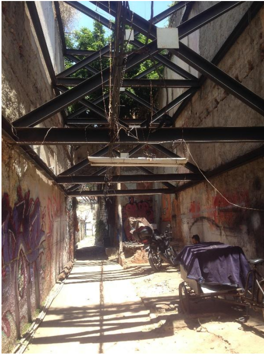
Figura 12: Acesso Avenida Modelo, com escoramentos.
