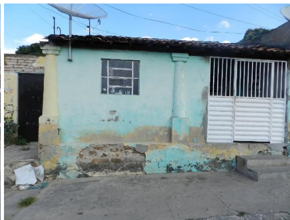
Figura 71: Rua Rui Barbosa, imóveis em processo de demolição, com as colunas em evidência. Fonte: Acervo da autora, 2017.
