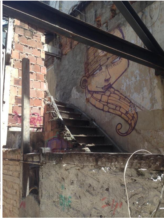
Figura 13: Acesso Avenida Modelo, com escoramentos.
