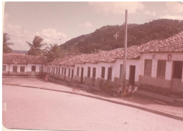
Figura 99: Imagens da Vila Operária de Fernão Velho existentes no processo. Fonte: Processo nº. 1242-T-87, IPHAN, 1983.
