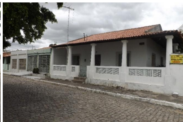
Figura 25: Remanescentes da antiga Vila Operária em Delmiro Gouveia – AL.
