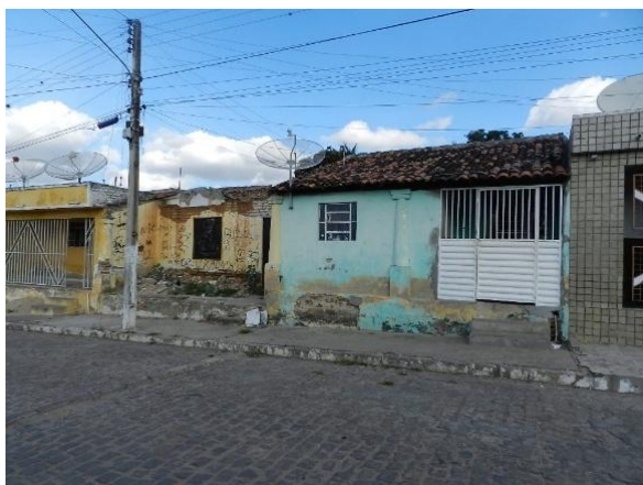
Figura 70: Rua Rui Barbosa, imóveis em processo de demolição, com as colunas em evidência. Fonte: Acervo da autora, 2017.
