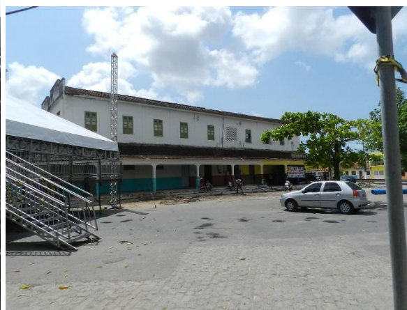
Figura 130: Fachada da antiga casa do proprietário voltada para Rua Dr. Manoel Machado.
