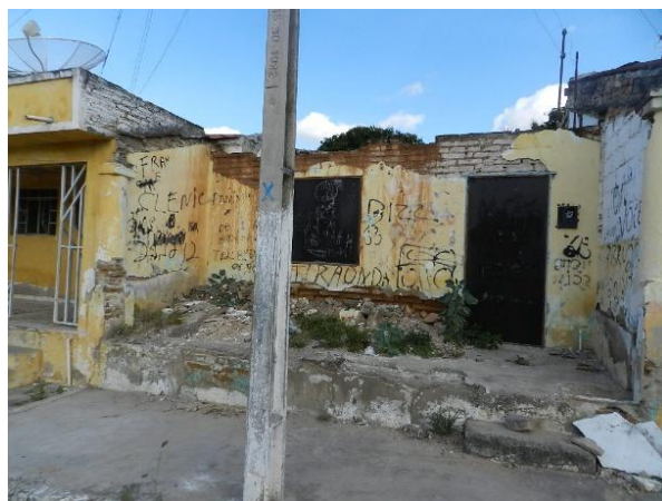
Figura 69: Rua Rui Barbosa, imóveis em processo de demolição, antiga área dos alpendres.
