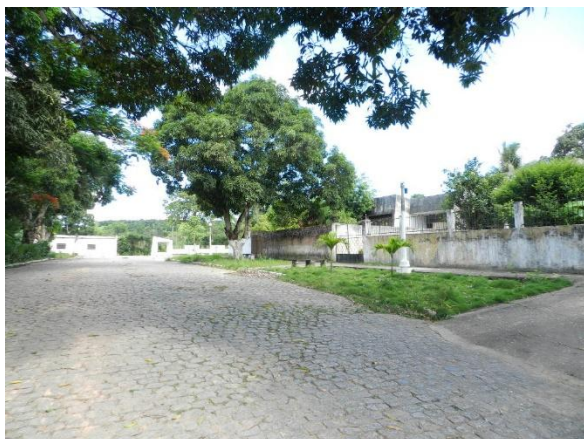
Figura 237: Aspecto geral da Vila dos Funcionários.
