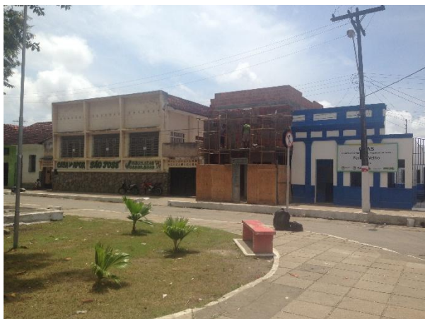
Figura 200: Edificação remanescente localizada na praça São José.
