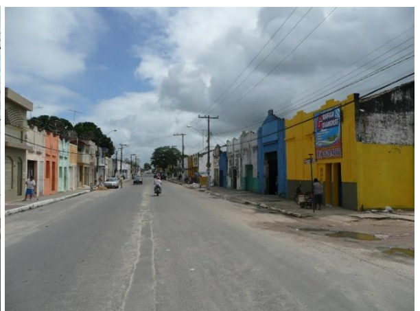
Figura 09: Vila Operária de Goiana, PE. Fonte: IPHAN – PE, 2009.
