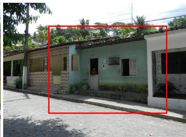
Figura 174: Rua da Lapinha, casas com alinhamento diferente da casa original. Fonte: Acervo da autora, 2018.
