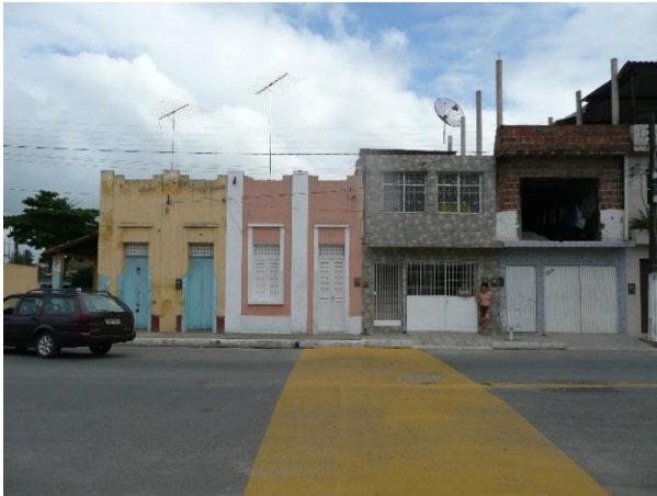
Figura 06: Vila Operária de Goiana, PE. Fonte: IPHAN – PE, 2009.
