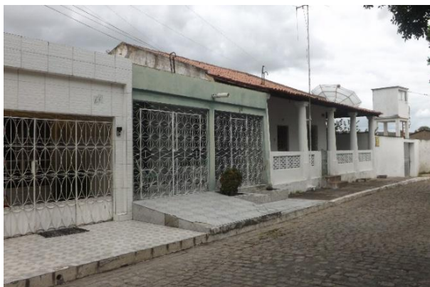
Figura 24: Remanescentes da antiga Vila Operária em Delmiro Gouveia – AL.
