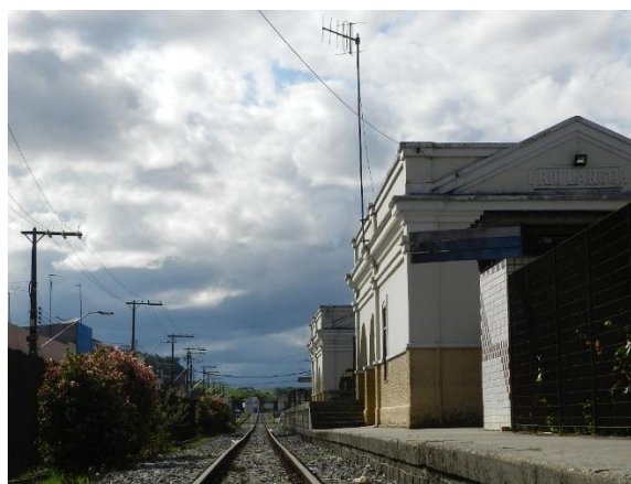
Figura 274: Estação Ferroviária de Rio Largo. Fonte: Paula Fernandes, 2018.
