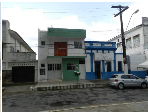
Figura 201: Edificação remanescente localizada na praça São José.
