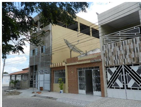
Figura 60: Rua Rio Branco, casas com acréscimos de pavimento.
