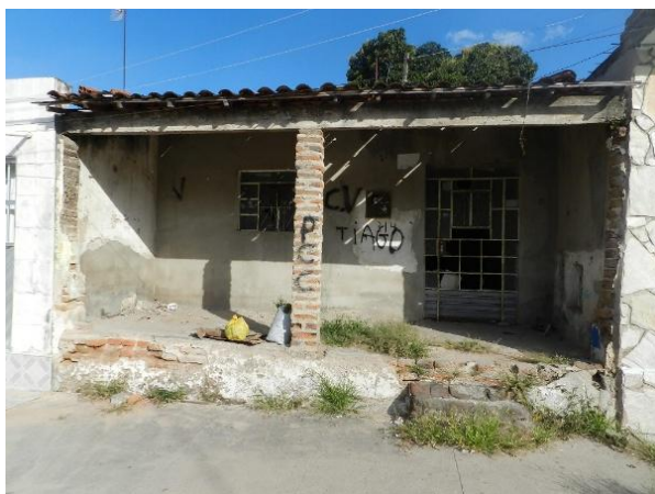
Figura 68: Rua Rui Barbosa, imóveis em processo de demolição, antiga área dos alpendres.
