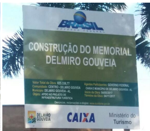
Figura 97: Placa da obra, com previsão de entrega para novembro de 2017 Fonte: Acervo da autora, 2017.
