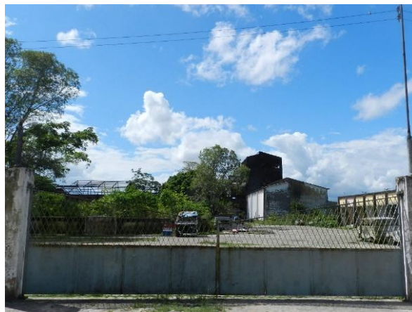
Figura 221: Demais edificações que formam a antiga Destilaria Central, sem acesso.
