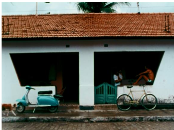
Figura 190: Rua da Praia, trecho com formas geométricas na fachada.
