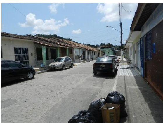
Figura 194: Vista geral da rua da Praia.
