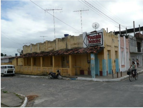
Figura 04: Vila Operária de Goiana, PE. Fonte: IPHAN – PE, 2009.
