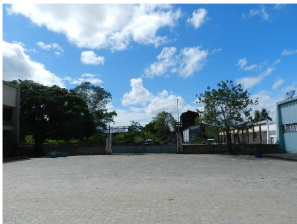
Figura 220: Demais edificações que formam a antiga Destilaria Central, sem acesso.
