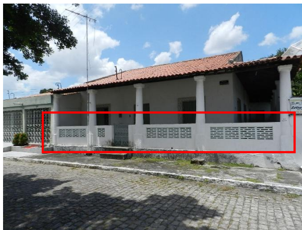
Figura 54: Casas com fechamento das colunas com cobogós, em destaque. Fonte: Acervo da autora, 2017.
