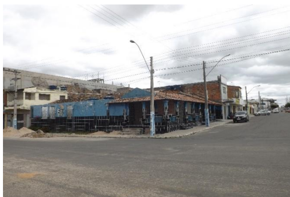
Figura 23: Remanescentes da antiga Vila Operária em Delmiro Gouveia – AL.
