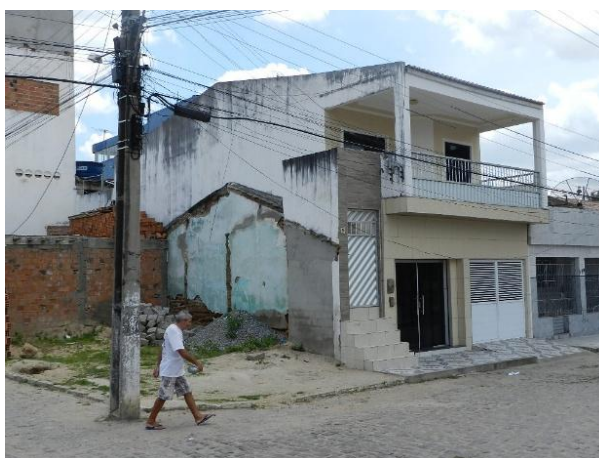
Figura 67: Rua Rio Branco, lote demolido, ainda com a marcação da cumeeira.
