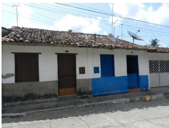
Figura 180: Remanescentes encontrados, na rua Dr. Manoel Machado. Fonte: Acervo da autora, 2018.
