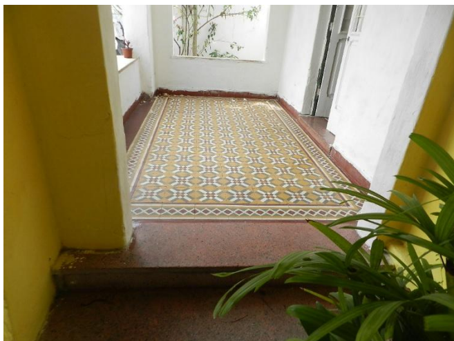
Figura 170: Detalhe do piso em ladrilho hidráulico original.
