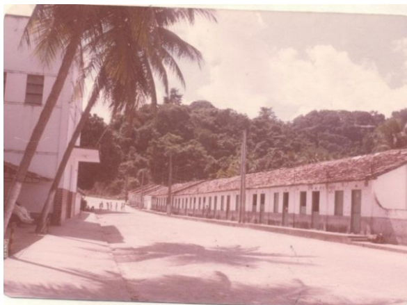
Figura 98: Imagens da Vila Operária de Fernão Velho existentes no processo. Fonte: Processo nº. 1242-T-87, IPHAN, 1983.
