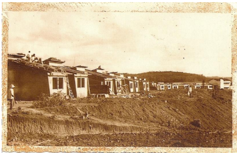
Figura 213: Vila Residencial da Destilaria Central de Alagoas em obra.
