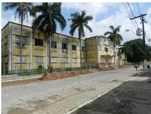
Figura 105: Vista da fachada voltada para a Rua Dr. Manoel Machado. Fonte: Acervo da autora, 2018.
