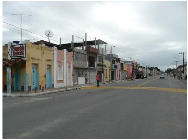
Figura 05: Vila Operária de Goiana, PE. Fonte: IPHAN – PE, 2009.
