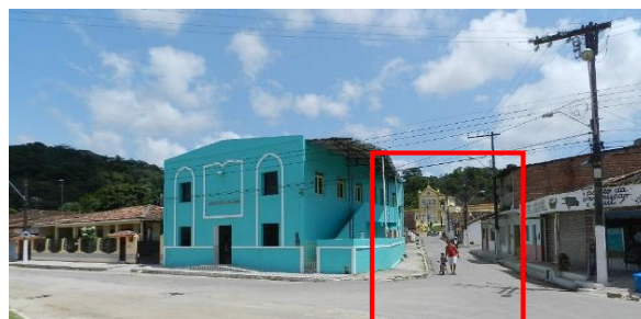
Figura 148: Edificação em primeiro plano (antigo Grupo Escolar), localizada na intersecção da Av. Dr. Alberto com a rua Dr. Artur Machado, e ao fundo visada da Igreja São José, em destaque.
