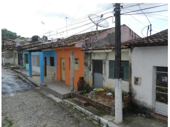
Figura 204: Arruamento existente no entorno da Praça Eduardo Santos.
