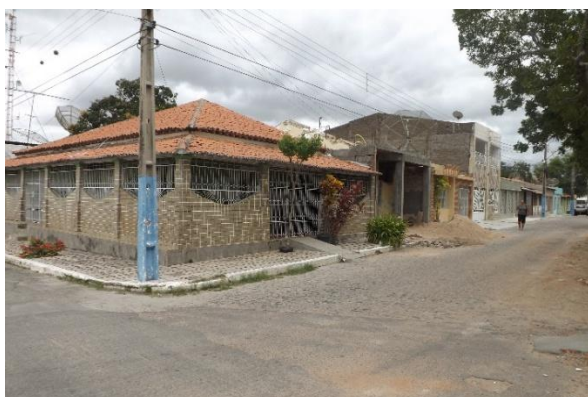
Figura 22: Remanescentes da antiga Vila Operária em Delmiro Gouveia – AL.
