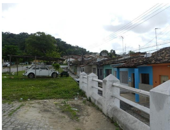
Figura 205: Arruamento existente no entorno da Praça Eduardo Santos.
