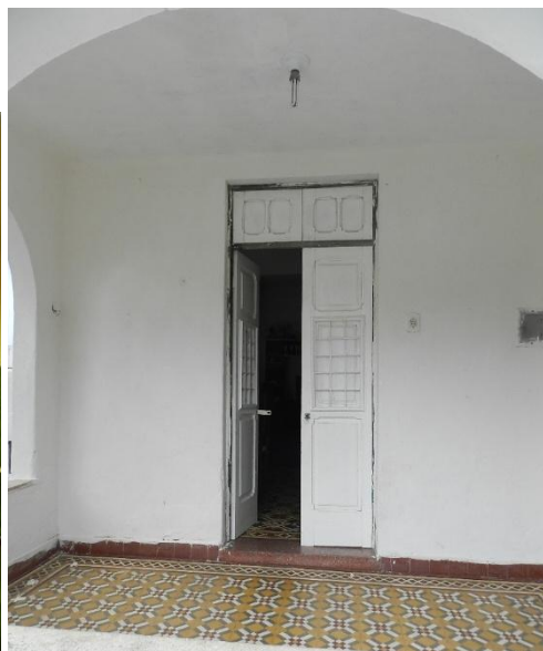
Figura 171: Detalhe do piso em ladrilho hidráulico original e da porta em madeira.
