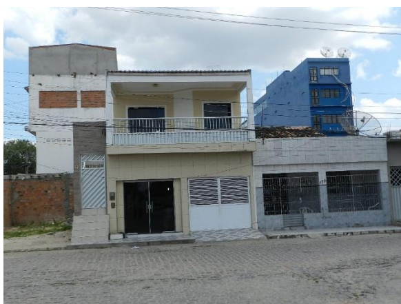
Figura 59: Rua Rio Branco, casas com acréscimos de pavimento.
