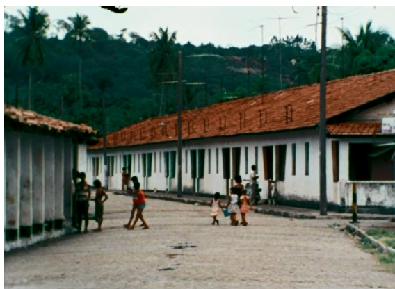
Figura 191: Rua da Praia, trecho com formas geométricas na fachada.
