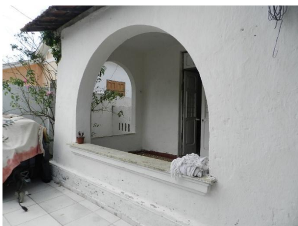
Figura 168: Vista interna de um dos imóveis, que mantém característica original preservada.
