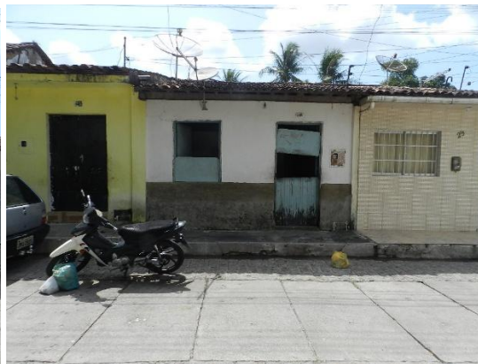
Figura 181: Remanescentes encontrados, na rua Dr. Manoel Machado. Fonte: Acervo da autora, 2018.
