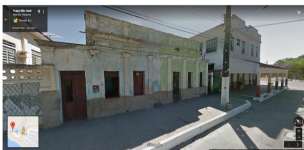
Figura 198: Edificação remanescente localizada na praça São José.
