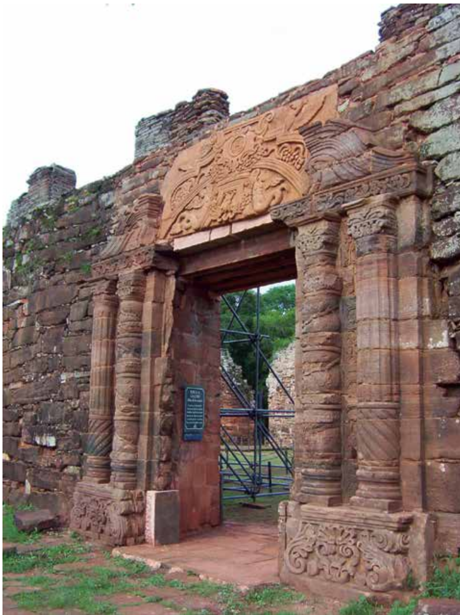
Foto 1: Portal lateral final
