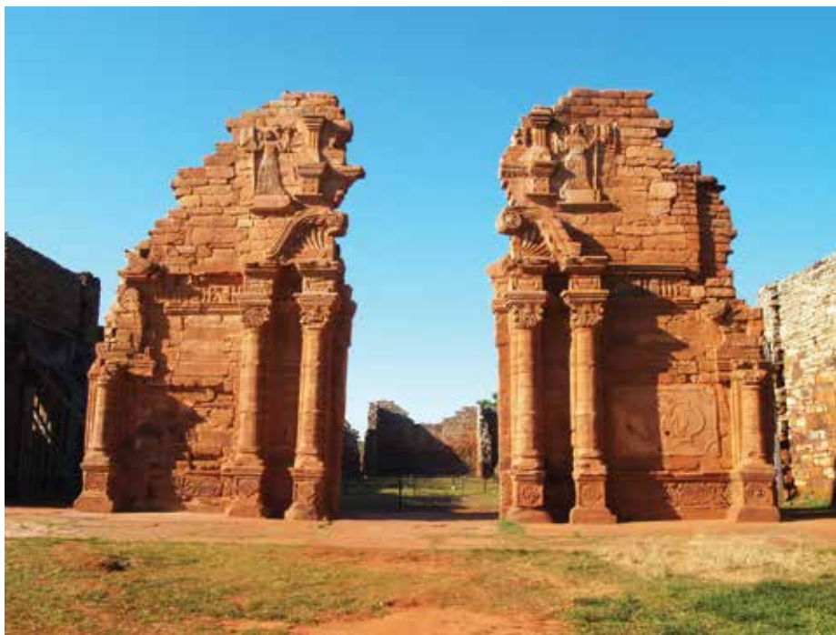
Foto 2: Portal principal da igreja ao final da intervenção
