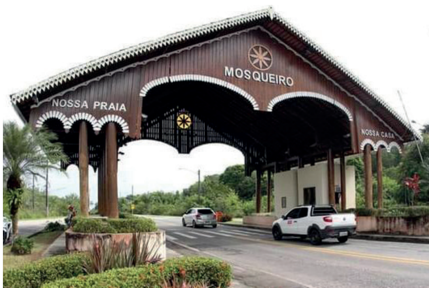
Pórtico de Mosqueiro. Foto: Giovanni Blanco Sarquis, 2012.
