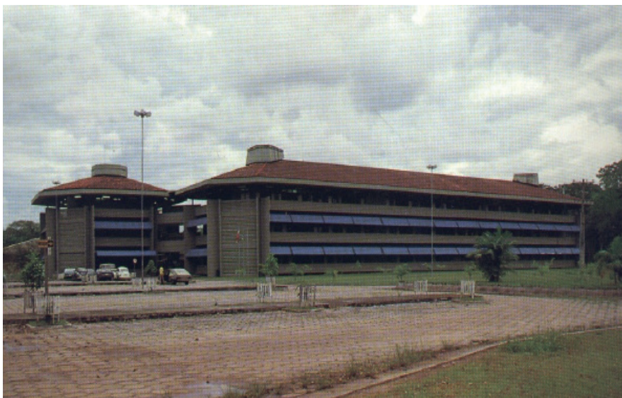
Edifício-sede da SEDUC [coautores: A. Meira, M. Monte e Reinaldo Jansen]. Fonte: Acervo de José Raiol.
