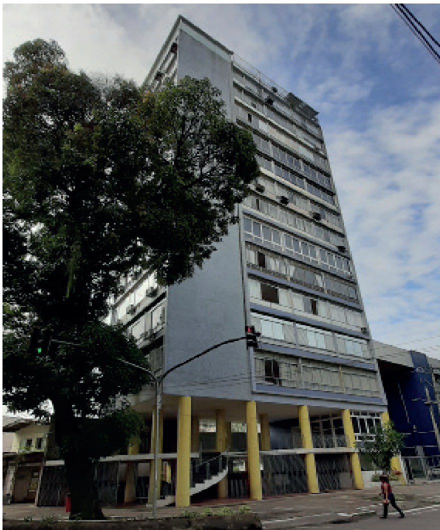
Edifício Felícia. Foto: Giovanni Blanco Sarquis, 2019.
