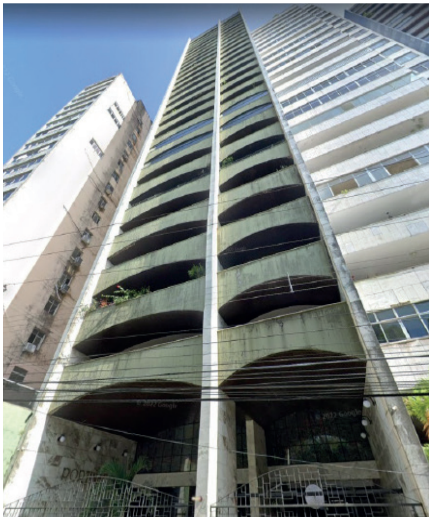
Edifício Portinari. Foto: Giovanni Blanco Sarquis, 2020.
