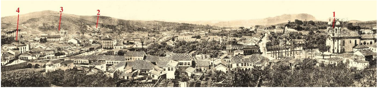
Figura 3: Panorâmica de São João del Rei – 1. Igreja de São Francisco de Assis; 2 - Igreja de N. Sra. do Carmo. 3- Matriz de N. Sra. do Pilar. 4 - Igreja de N. Sra. do Rosário. Foto: André Bello [adaptada]. Data: [1910].
