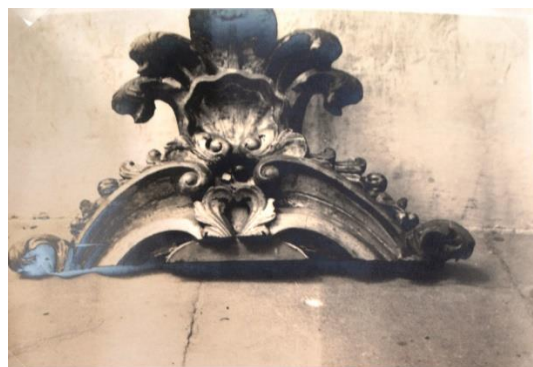
Figura 105: Mesmo elemento da figura 104 após restauração. Fonte: ACI-RJ / Série CRBC. Data: 1970
