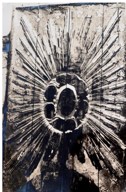
Figura 116: Alto relevo do fundo "original" do retábulo parcialmente destruído para adaptação do fundo novo. Fonte: ACI-RJ / Série CRBC. Data: 1970.
