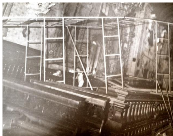
Figura 77: Queda de andaime que ocasionou a quebra do lustre da igreja (informação no verso da fotografia original). Fonte ACI-RJ / Série CRBC. Data: 1961
