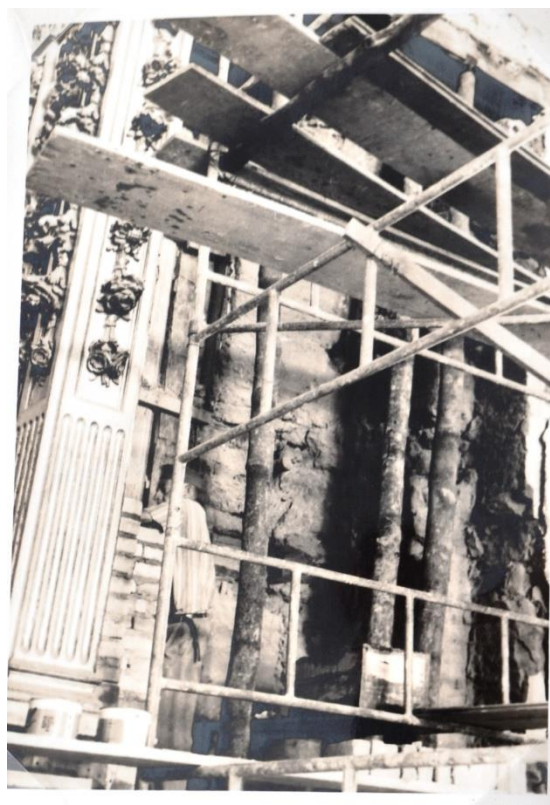
Figura 98: Escoramento da parede de taipa e início das obras de pilastras de tijolos. Fonte: ACI-RJ / Série CRBC. Data: 1970
