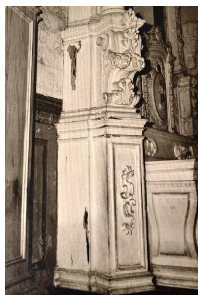
Figura 84: Galerias de insetos aparentes no retábulo lateral. Fonte ACI-RJ / Série CRBC. Data: 1961
