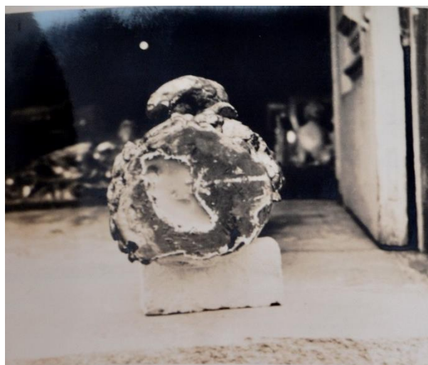
Figura 114: Mesma pilastra da figura 113 após preenchimento com cera e pedaços de cedro. Fonte: ACI-RJ / Série CRBC. Data: 1970
