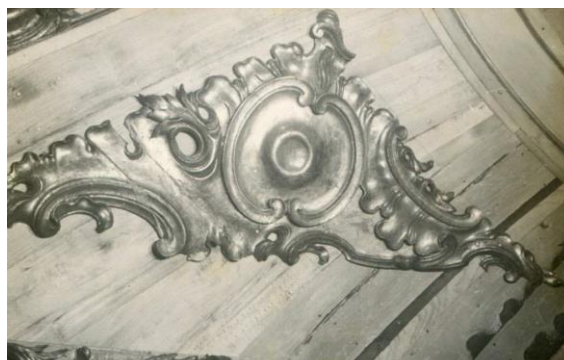
Figura 51: Elemento entalhado já solidificado, douramento recuperado - fixado no tabuado novo. Fonte: ACI-RJ / Série CRBC. Data: 1958.
