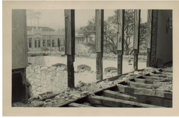
Figura 27: Demolição do casarão. Fonte: Acervo ETSJDR. Data: 1946
