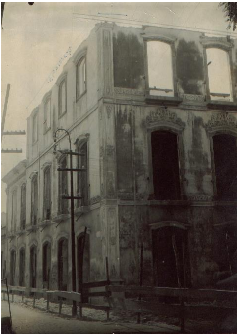
Figura 28: Demolição parcial do casarão e estudo para recomposição da fachada. Fonte: Acervo ETSJDR. Data: 1946
