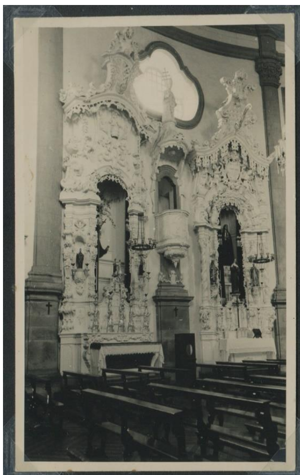
Figura 87: Aspecto dos retábulos da nave da Igreja de São Francisco de Assis antes da remoção da camada de gesso branca. Fonte: ACI-RJ / Série Inventário. Data: [1956]
