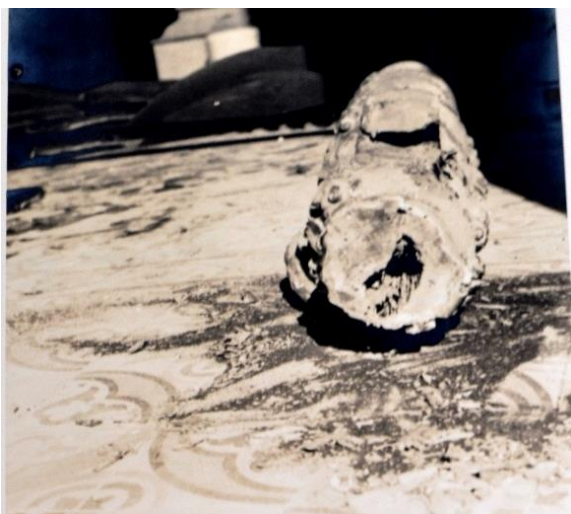
Figura 113: Pilastra com galerias profundas de cupins. Fonte: ACI-RJ / Série CRBC. Data: 1970.
