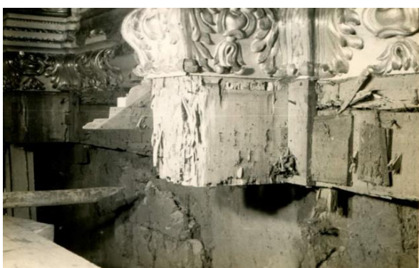
Figura 43: Peça atacada por térmita. Fonte: ACI-RJ / Série CRBC. Data: 1958.
