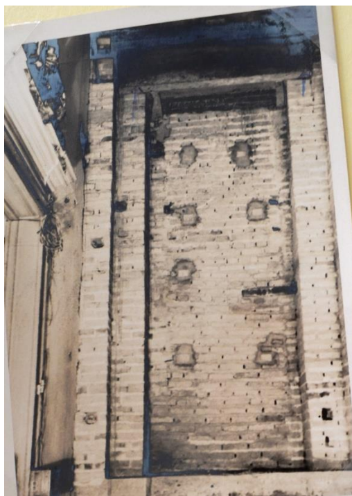
Figura 121: Colunas de tijolos e viga de concreto já prontas. Fonte: ACI-RJ / Série CRBC. Data: 1970
