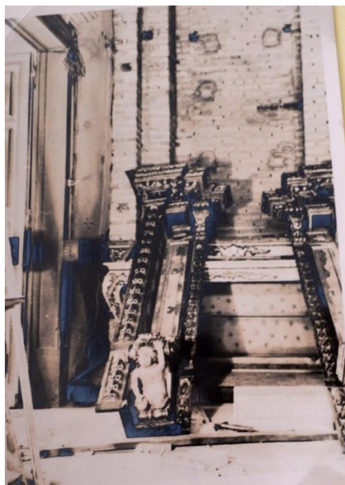
Figura 122: Início da remontagem do retábulo de N. Sra. da Boa Morte. Fonte: ACI-RJ / Série CRBC. Data: 1970
