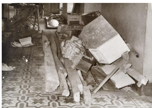
Figura 81: Preparação para instalação da obra. Fonte ACI-RJ / Série CRBC. Data: 1961
