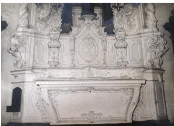
Figura 94: Antes da remoção do gesso. Fonte: Fonte: ACI-RJ / Série CRBC. Data: 1962
