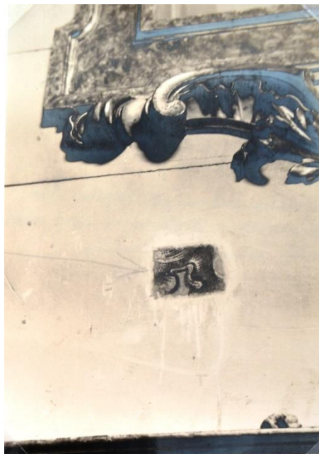
Figura 145: Parede lateral da capela-mor revestida por painéis de madeira: teste de remoção de repintura. Fonte: ACI-RJ / Série CRBC. Data:1971
