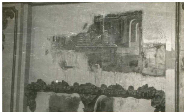
Figura 63: Pannel lateral da capela-mor. Fonte: ACI-RJ / Série CRBC. Data: 1958.
