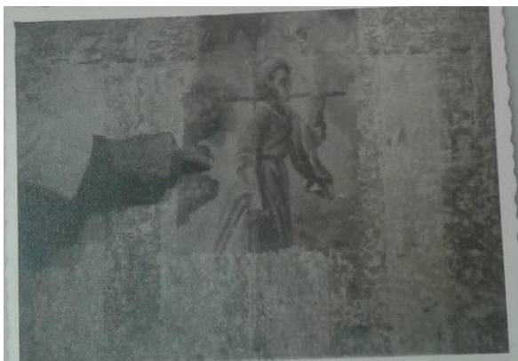
Figura 65: Processo de restauração das pinturas dos painéis da capela-mor: cenas do antigo testamento. Fonte: CDI. Data: 1958.
