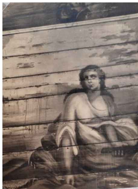
Figura 143: detalhe do estado de conservação do forro da sacristia. Fonte: ACI-RJ / Série CRBC. Data: 1971
