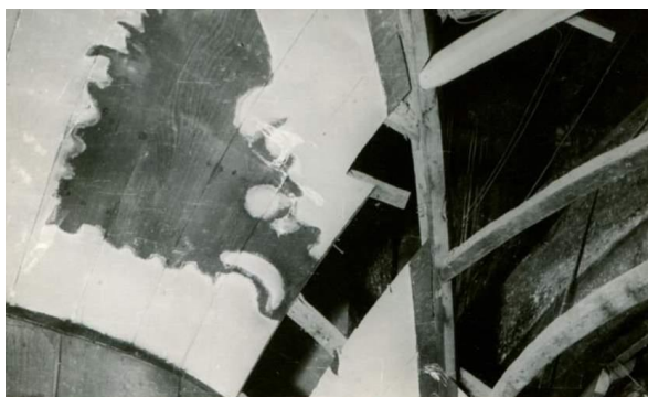
Figura 50: Tábuas de cor branca foram substituídas - o elemento entalhado foi removido e tratado para ser reaplicado no novo tabuado. Fonte: ACI-RJ / Série CRBC. Data: 1958.
