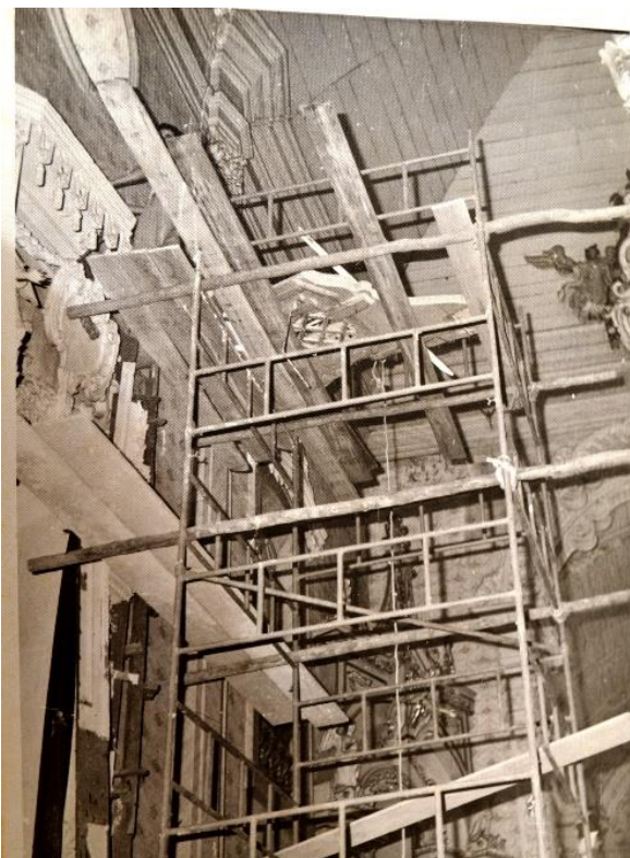
Figura 79: Andaime montado. Fonte ACI-RJ / Série CRBC. Data: 1961
