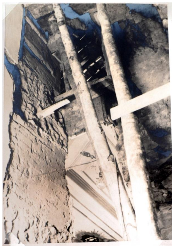
Figura 120: Escoramento da parede, e remoção da taipa solta que forçava o retábulo de N. Sra. da Boa Morte, ao fundo aparece a capela do SS sacramento. Fonte: ACI-RJ / Série CRBC. Data: 1970
