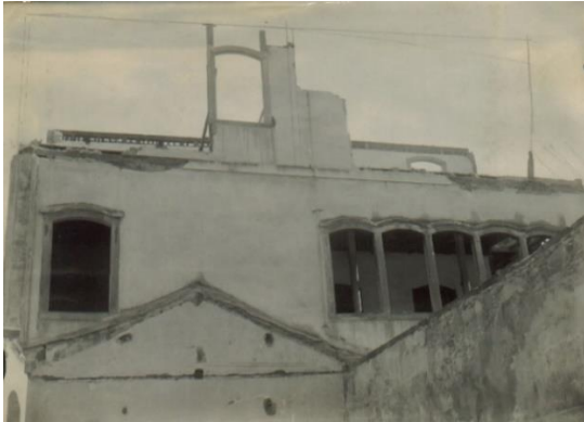
Figura 26: Demolição parcial do casarão. Fonte: Acervo ETSJDR. Data: 1946
