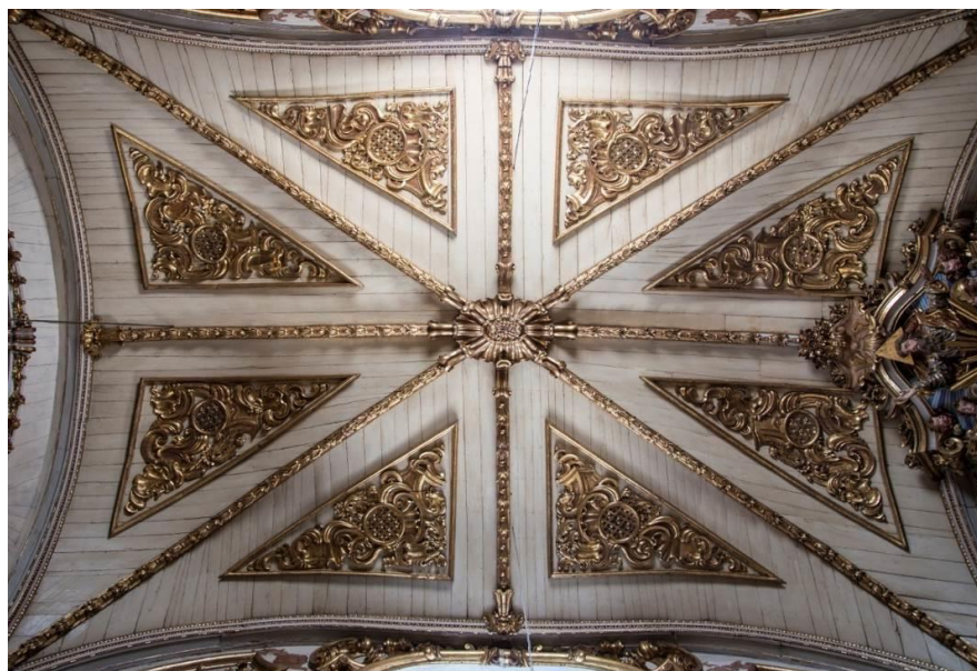
Figura 59: Foto atual Forro da Capela-mor. Acervo ETSJD (IPHAN, 2016). Foto de Miguel Aun. Data 2015
