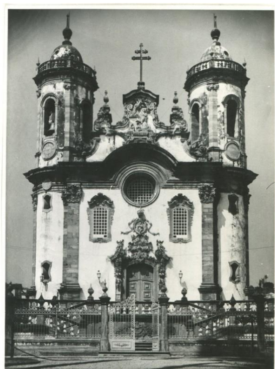
Figura 23: Fachada frontal da Igreja de São Francisco de Assis - Fonte: ACI-RJ/Série Inventário. Data: década de 1940
