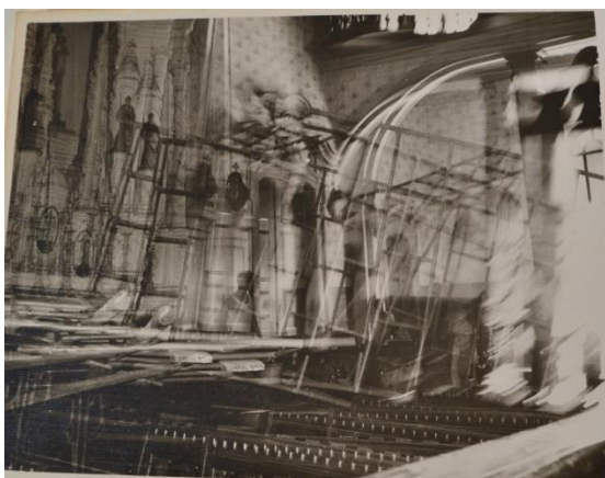
Figura 76: Queda de andaime durante restauração na igreja de N. Sra. do Carmo de SJDR. Fonte: ACI-RJ / Série CRBC. Data: 1961
