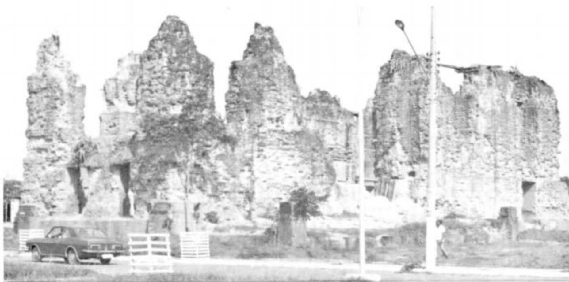
Ruínas da Igreja Matriz
