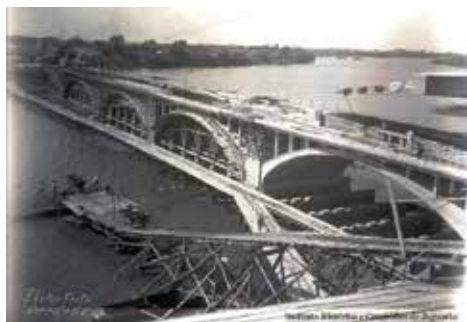
Construção dos arcos que suportam o tabuleiro, 1928. Fonte: Instituto Histórico e Geográfico de Jaguarão.
