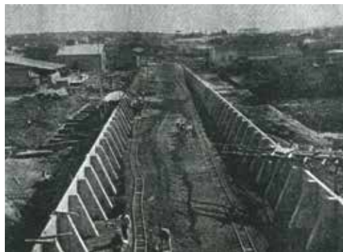
Construção do muro de contenção da rampa do acesso brasileiro, 1928. Fonte: Ministerio de Educación y Cultura.
