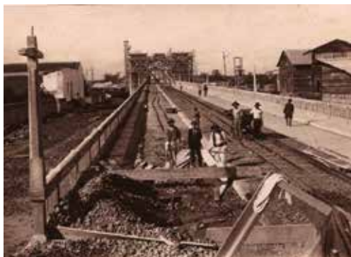
Construção da rampa do lado brasileiro, sem data. Fonte: Instituto Histórico e Geográfico de Jaguarão.
