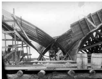
Estrutura para a construção dos arcos, 1928. Fonte: Instituto Histórico e Geográfico de Jaguarão.
