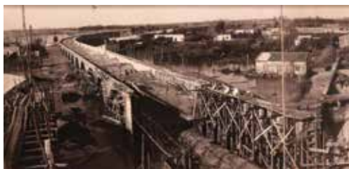
Construção da rampa do lado uruguaio, sem data. Fonte: Instituto Histórico e Geográfico de Jaguarão.
