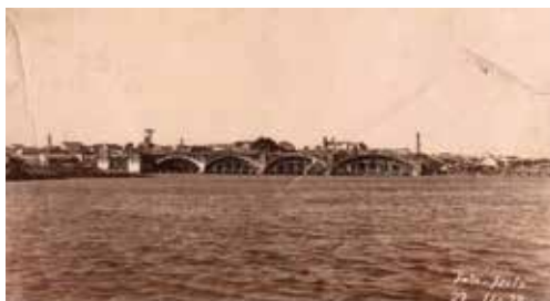
Construção dos arcos que suportam o tabuleiro superior, 1928. Fonte: Instituto Histórico e Geográfico de Jaguarão.
